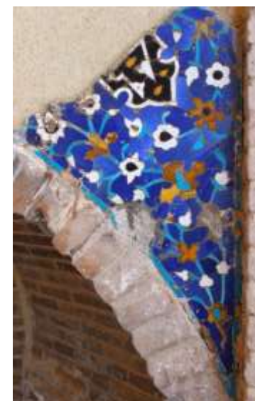
چند نمونه از بخش کاشی های تزئینی که در ساحه یافت و در جریان کار پروژه شهزاده عبدالله مرمت و یا تحکیم کاری گردید.
