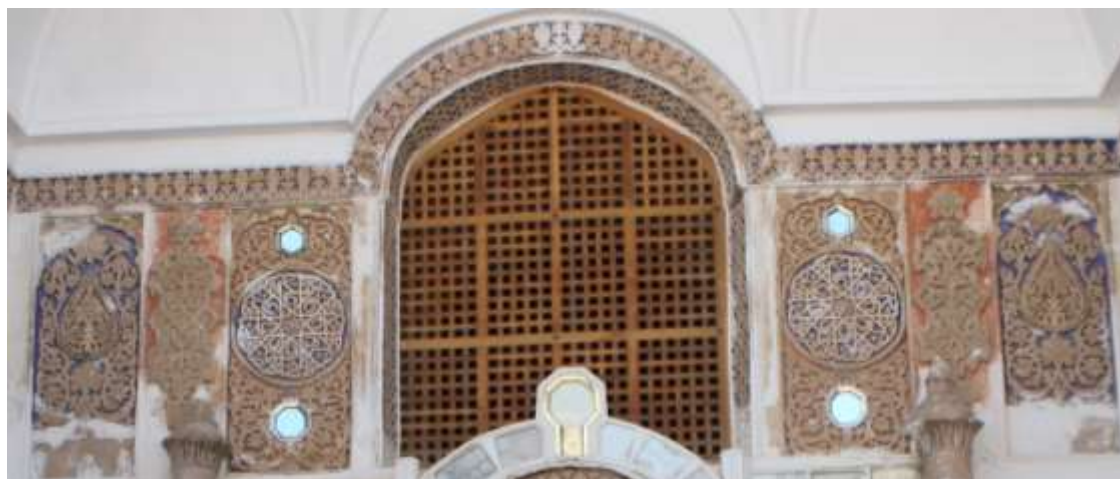
جالی چوبی شبکه دار بالای دروازه ورودی نیز ترمیم گردید.
